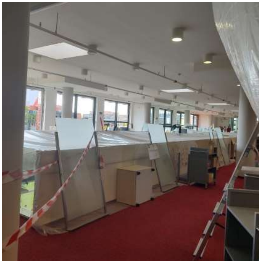
Výměna oken na budově AK
